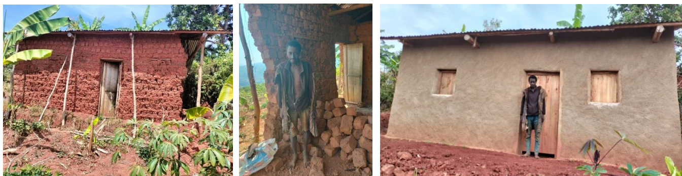
Dit huisje stond op instorten, bewoond door deze man, nu is het eindelijk bewoonbaar gemaakt met onze hulp
